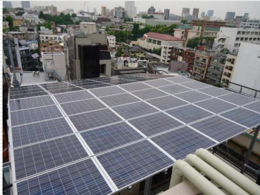
2012.05.17～稼働を開始した 麻布十番本社ビル屋上に設置した 太陽光パネル54枚 9.8kw
