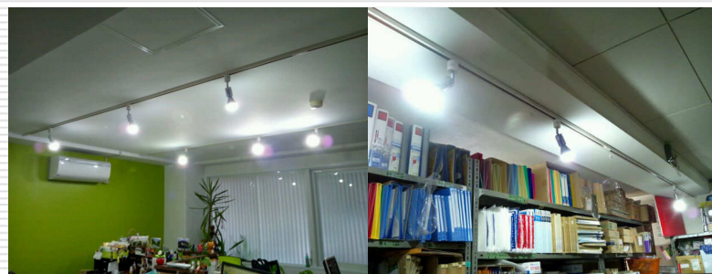
本社オフィスや店舗のスポットはLED照明を使用
