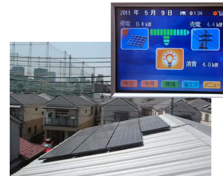
東陽センター ソーラー設備 10kw
