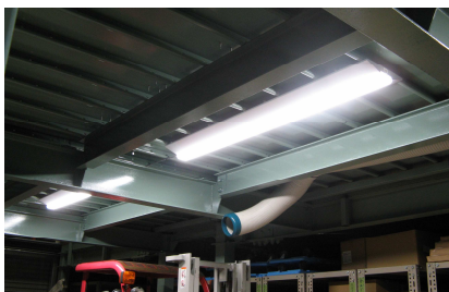
2018/5導入 新型LED照明(全9台)
