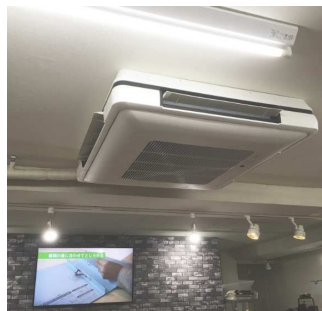
2016/6換装 小売事業部エアコン
