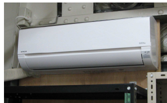
2018/5導入 新作業室用エアコン
