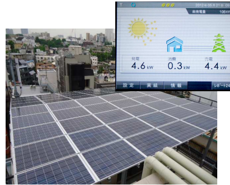
本社 ソーラー設備 9.8kw
