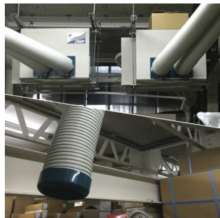
2016/6導入 スポットエアコン
