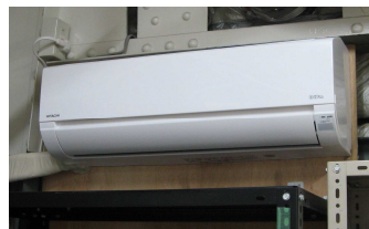
2018/5導入 新作業室用エアコン
