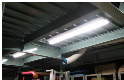
2018/5導入 新型LED照明(全9台)
