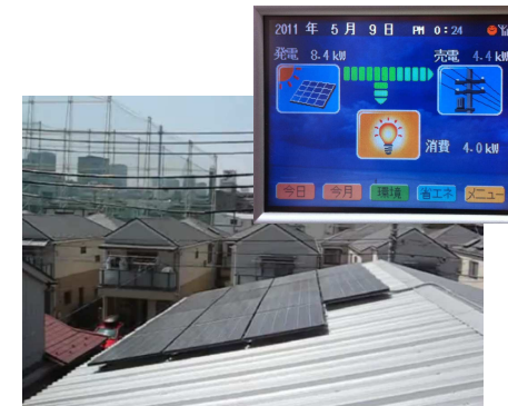
東陽センター ソーラー設備 10kw (今期の年間発電量: 11536kWh)
