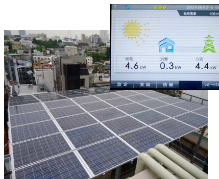
本社 ソーラー設備 9.8kw (今期の年間発電量: 10876kWh)
