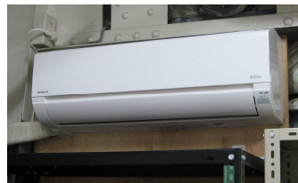
2018/5導入 新作業室用エアコン
