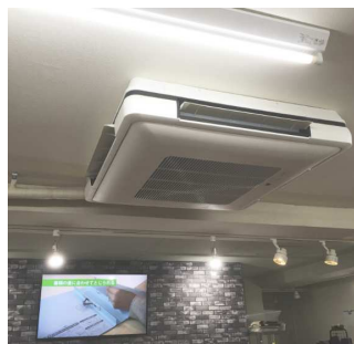
2016/6換装 小売事業部エアコン
