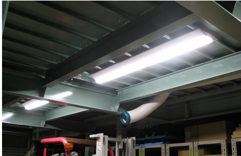
2018/5導入 新型LED照明(全9台)
