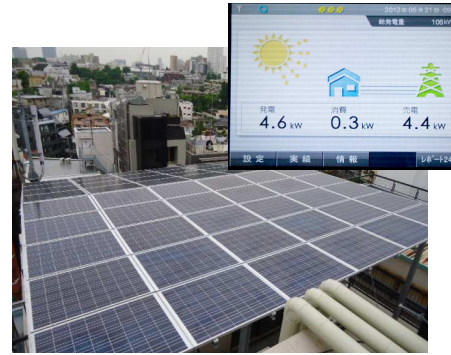
本社 ソーラー設備 9.8kw 今期の年間発電量：9053kWh 2012年4月からの累計：93311kWh
