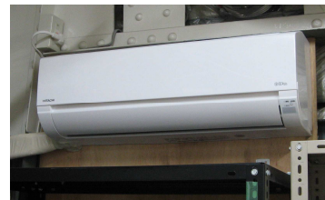
2018/5導入 新作業室用エアコン
