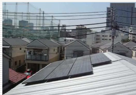
2010.08～稼働中の東陽センター 屋根の太陽光パネル10kw
